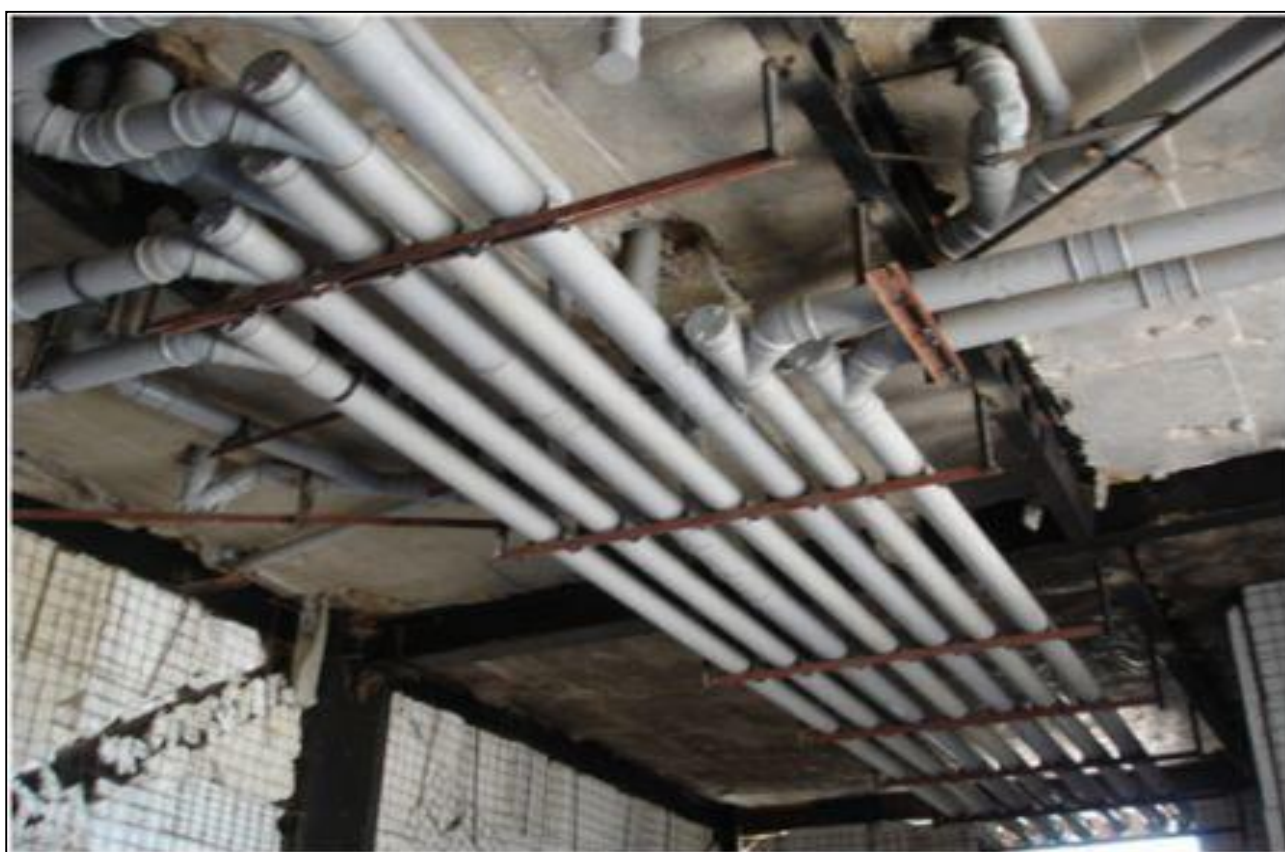
نصب لوله بصورت افقی
